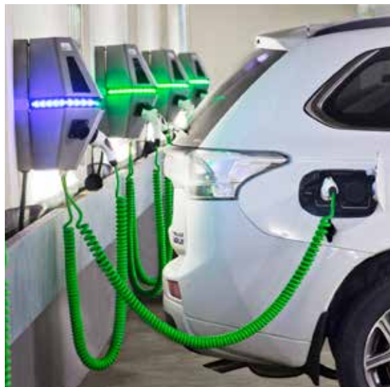
Elbil vid laddstation ca år 2017. Foto: Charge Storm.
